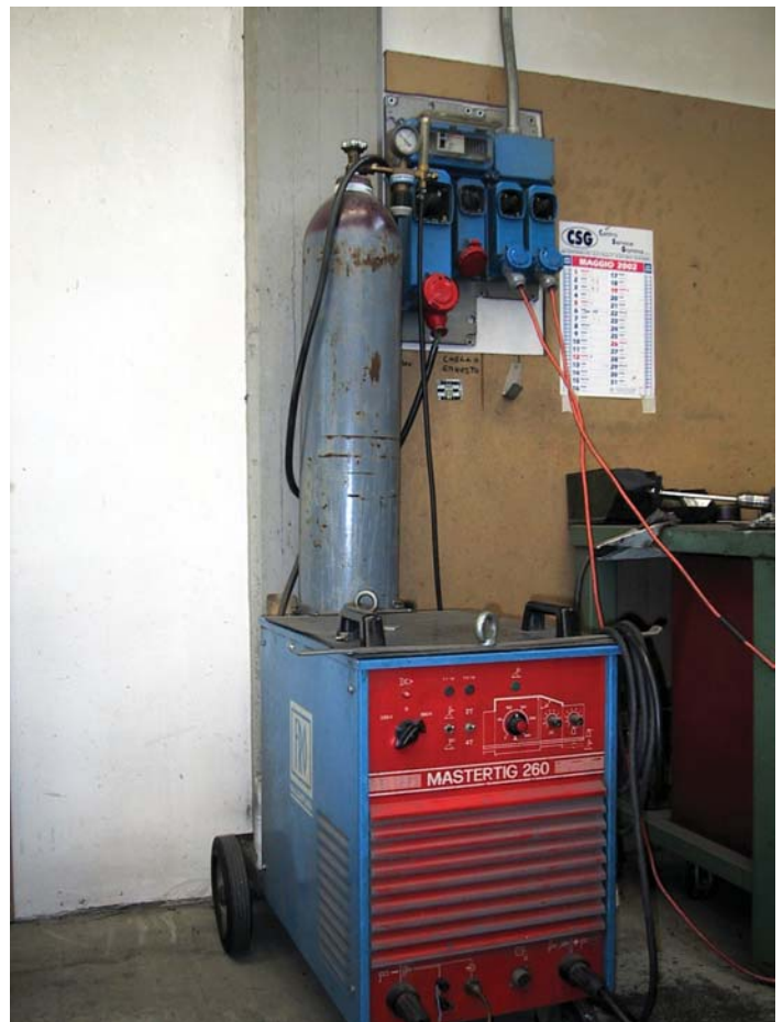
Figura 1 – Generatore e bombola di gas inerte
